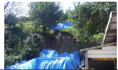
斜面崩壊・被災状況（H30年7月）
